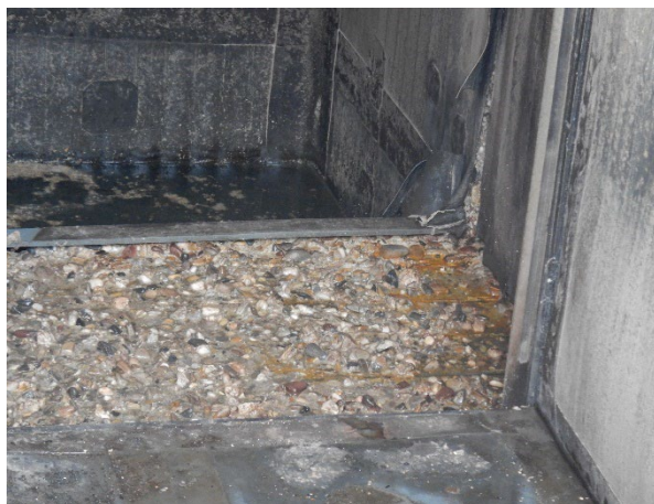
Foto 3.39: Vloeroppervlak sterk aangetast, wapening lokaal zichtbaar.
