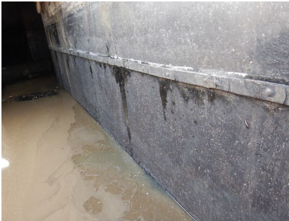
Figuur 3.45: Onderzijde knelstrips sluiten niet waterdicht af.
