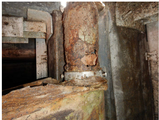
Foto 3.54: Scharnierpunt geheel door gecorrodeerd, detailfoto.
