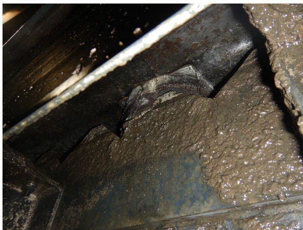
Foto 3.21: Lining poertje intact, geen aantasting beton.
