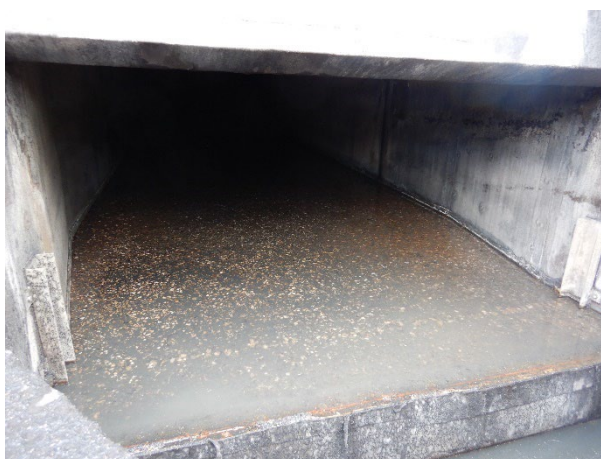
Foto 3.40: Vloeroppervlak sterk aangetast, wapening lokaal zichtbaar.
