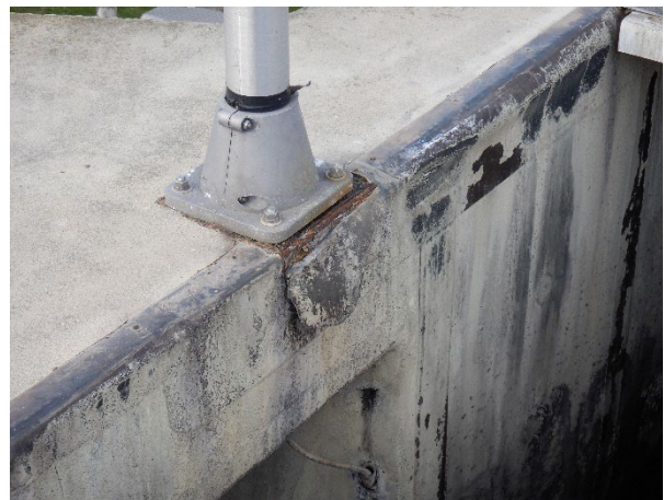
Foto 3.50: Lining los/gescheurd door corrosie voetplaat.
