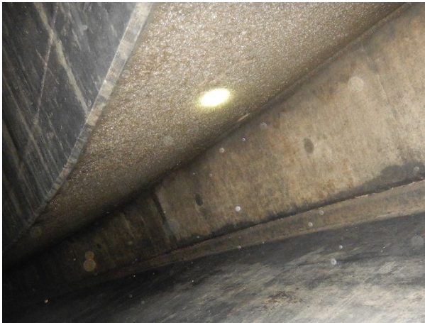
Foto 3.3: Onderzijde omloopgoot niet gereinigd.
