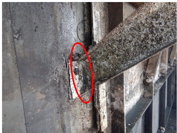
Foto 3.31: Stalen IPE-profiel geheel door gecorrodeerd.
