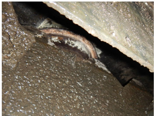
Foto 3.20: Lining rondom poertje open, beton poertje aangetast.
