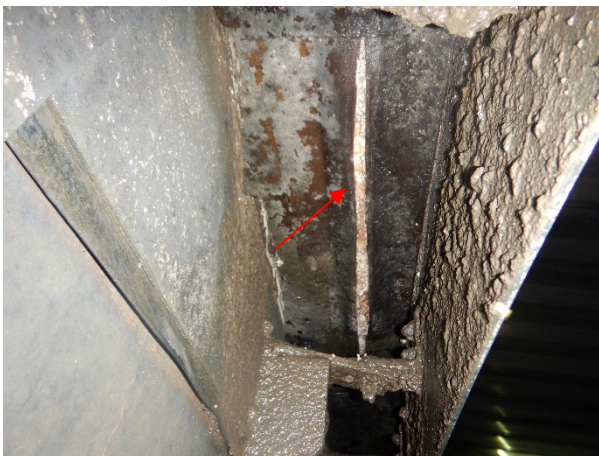
Foto 3.17: Lining onderzijde omlooprand gescheurd/open, beton sterk aangetast.
