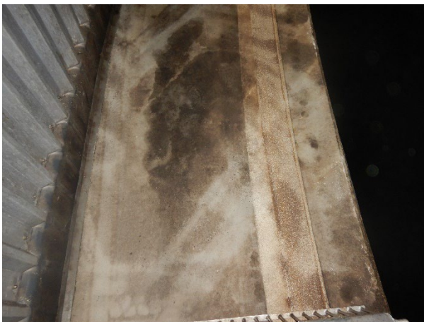
Foto 3.11: Bovenaanzicht slijtlaag omloopbaan.
