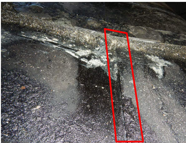
Foto 3.47: Knelstrip kan niet goed aansluiten door het niet vlakke deel in betonoppervlak
