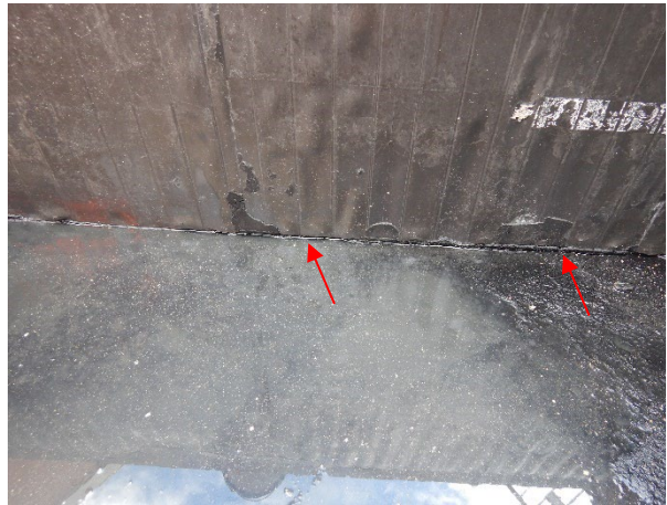
Foto 3.27: Lining aan onderzijde wand A staat open.
