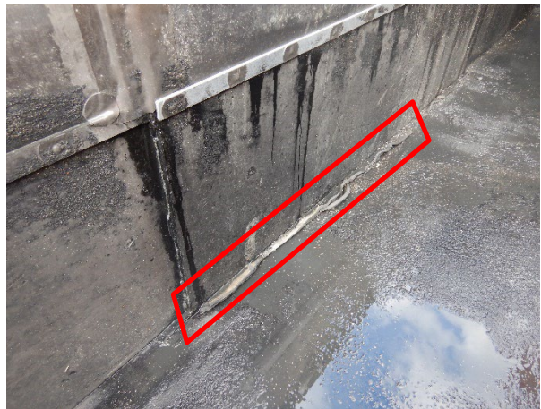
Foto 3.35: Rubberprofiel in onderzijde wand E deels los.
