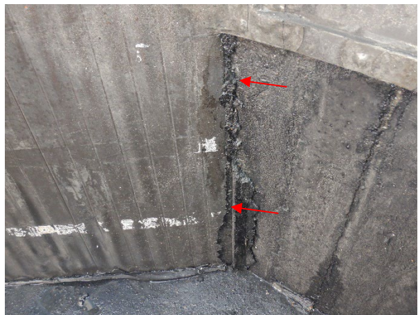
Foto 3.29: Lining langs zijkant wand A staat open.
