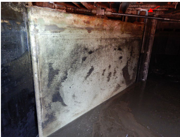
Foto 3.53: Scharnierpunt geheel door gecorrodeerd.
