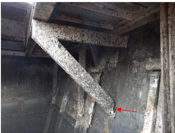
Foto 3.30: Stalen IPE-profiel geheel door gecorrodeerd.
