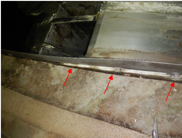
Foto 3.9: (Giet)mortel tussen instroombak en omloopgoot los/afgedrukt.
