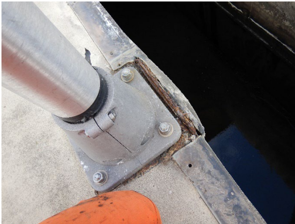
Foto 3.51: Lining los/gescheurd door corrosie voetplaat.
