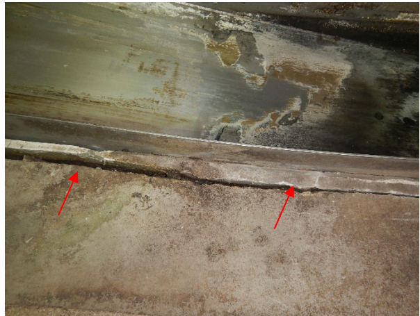
Foto 3.10: (Giet)mortel tussen instroombak en omloopgoot los/afgedrukt.
