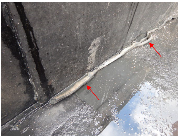
Foto 3.36: Rubberprofiel in onderzijde wand E deels los.
