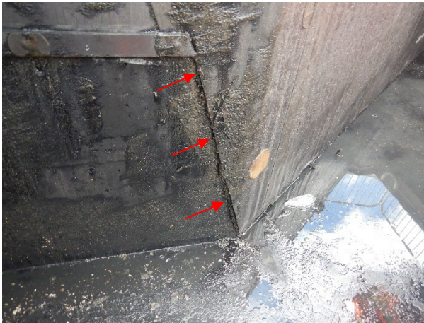
Foto 3.26: Lining langs zijkant wand A staat open.
