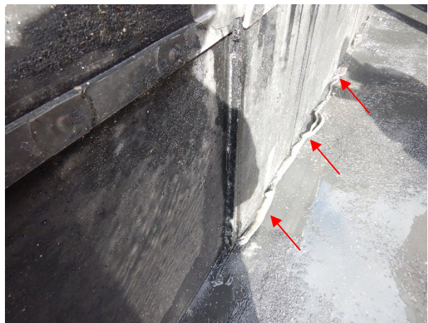
Foto 3.37: Rubberprofiel in onderzijde wand E deels los.
