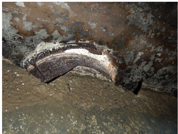
Foto 3.18: Lining rondom poertje open, beton poertje aangetast.
