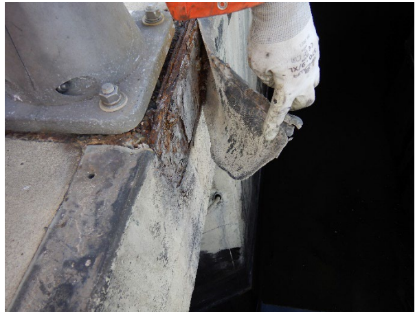
Foto 3.52: Lining los/gescheurd door corrosie voetplaat.
