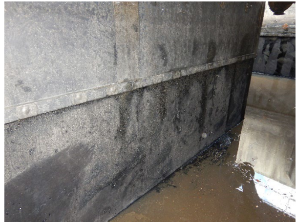
Figuur 3.46: Onderzijde knelstrips sluiten niet waterdicht af.
