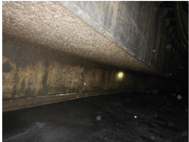
Foto 3.4: Onderzijde omloopgoot niet gereinigd.
