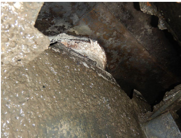
Foto 3.19: Lining rondom poertje open, beton poertje aangetast.
