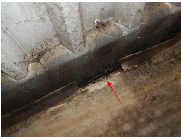
Foto 3.13: Open ruimte tussen voegprofielen, onderliggend beton licht-matig aangetast.
