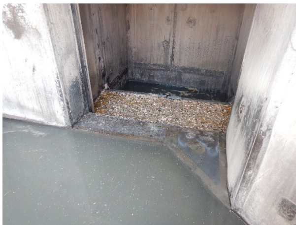
Foto 3.38: Vloeroppervlak sterk aangetast, wapening lokaal zichtbaar.
