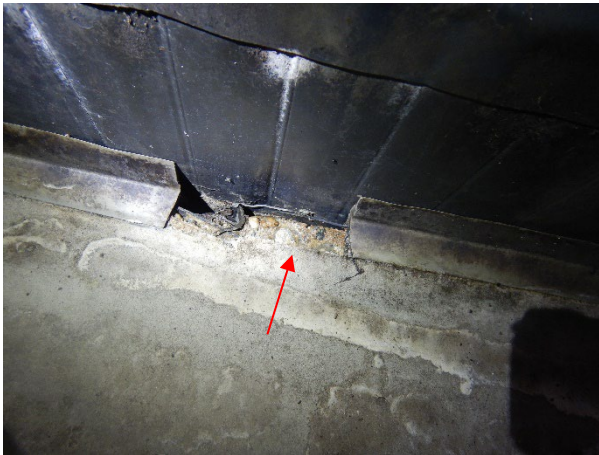
Foto 3.15: Open ruimte tussen voegprofielen, onderliggend beton licht-matig aangetast.
