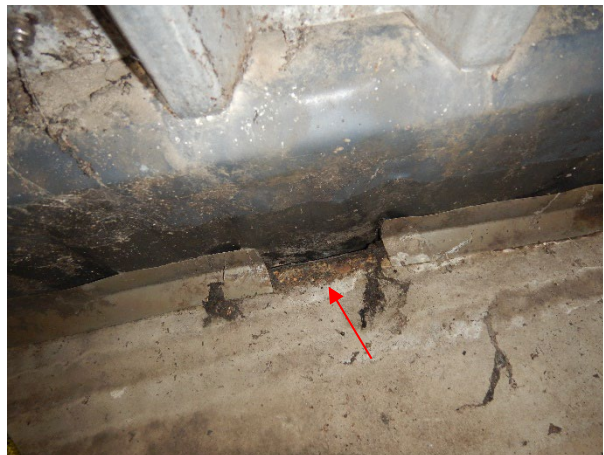
Foto 3.14: Open ruimte tussen voegprofielen, onderliggend beton licht-matig aangetast.
