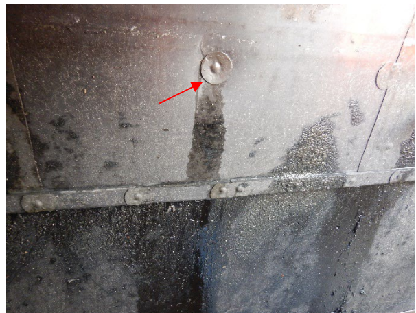
Foto 3.48: Lekkage langs afdekking bevestigingsring.
